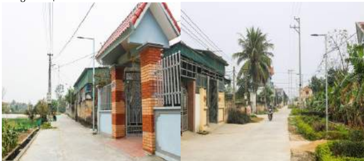
Hình 1.2. Hiện trạng tuyến đường xã Hoàng Đông khu vực dự án
